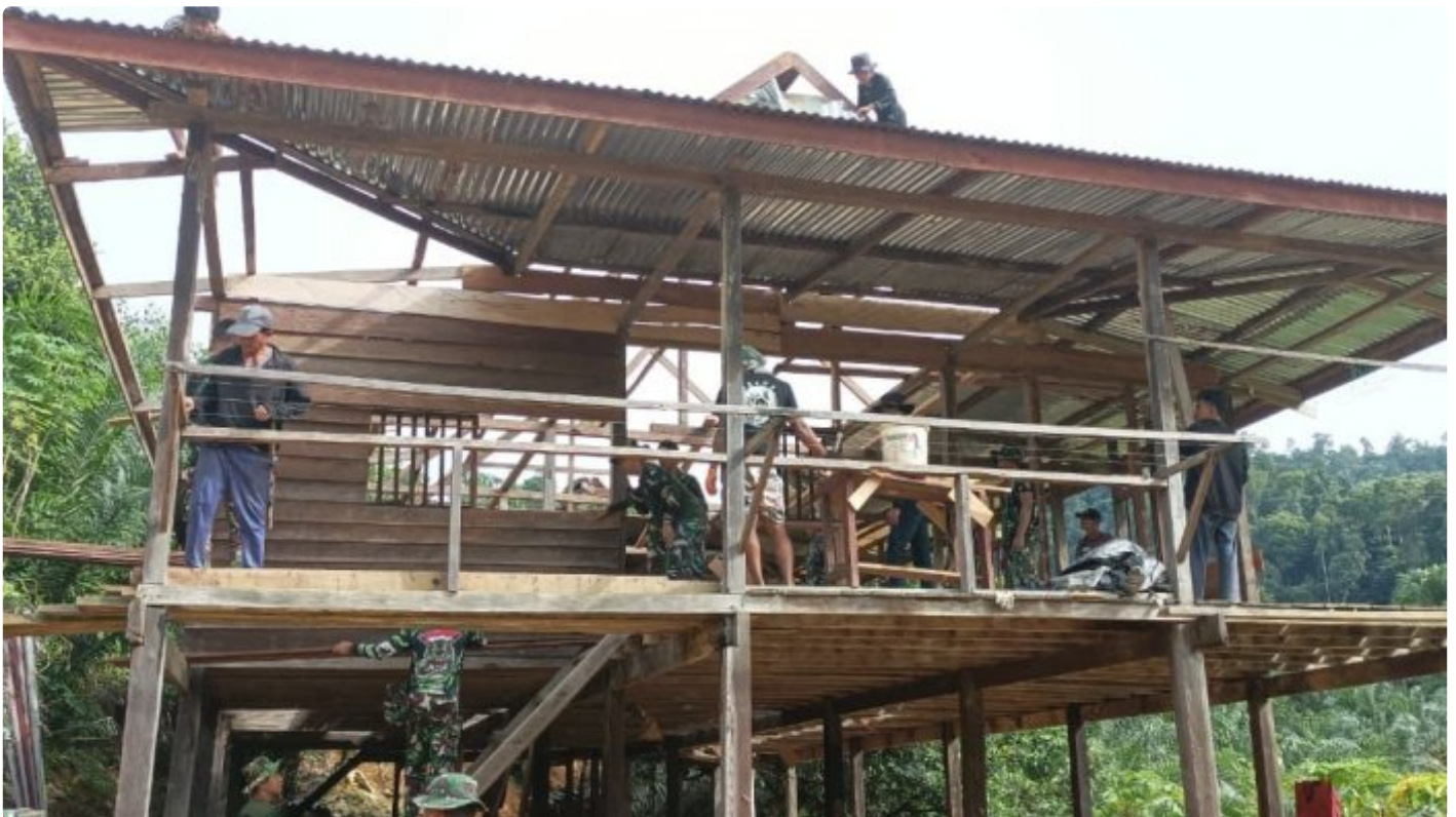
Foto Pembongkaran Rumah Warga
